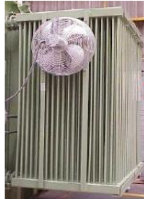
Radiador de tipo tubular
