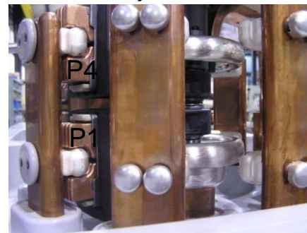
Contactos fijos del selector
